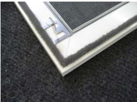
Fertig montierte Bürstendichtung.
