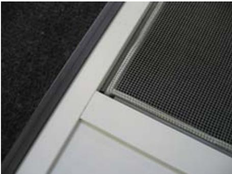
Zu den Sprossen hin kann der Keder nicht um die Ecke geführt werden sondern muss hier abgeschnitten werden.
