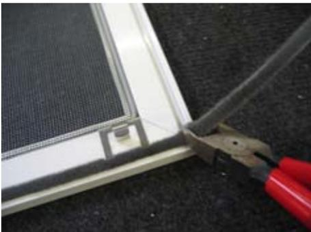
An den Ecken muss die Bürstendichtung abgeschnitten werden.
